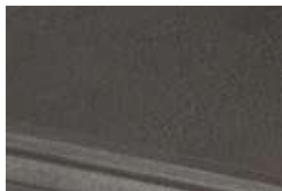
Detalle textura techo.
