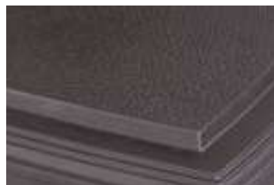
Detalle textura techo.
